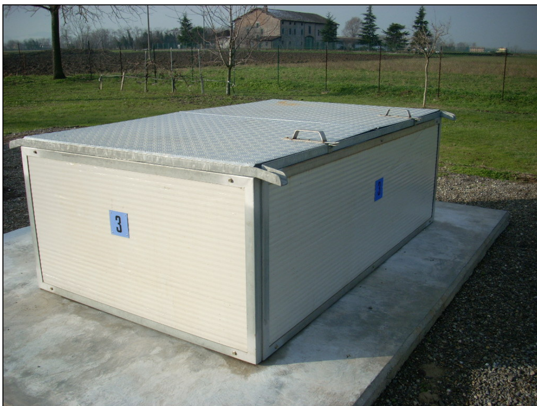
Fig. 26 Vista esterno manufatto scatolare mobile di chiusura testata pozzo in progetto.
